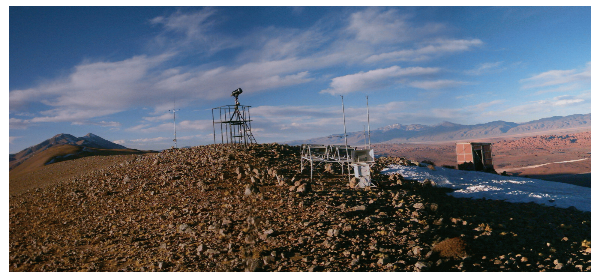
Figura 4: Equipo actualmente instalado (4600 mts)
