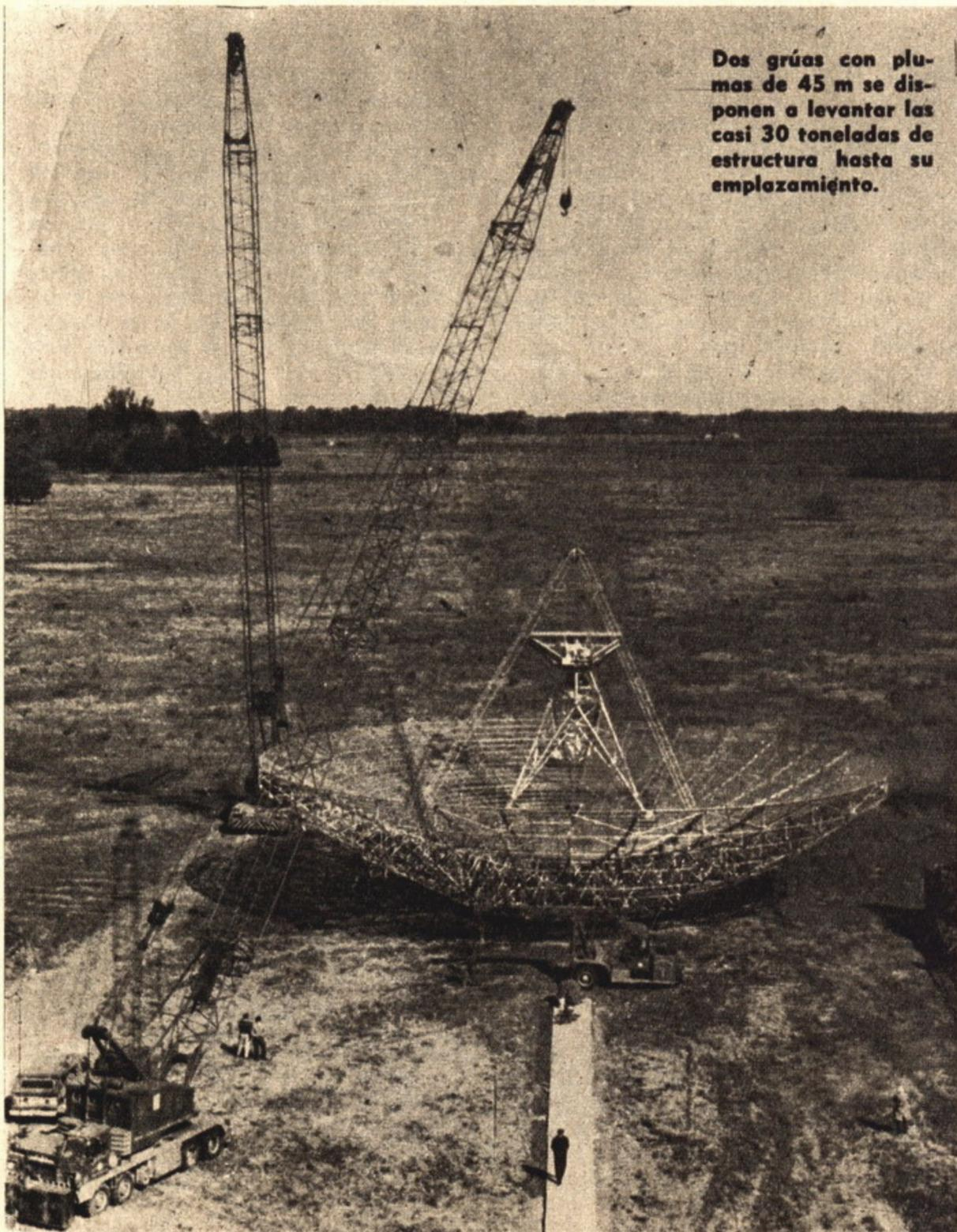
Dos grúas con plumas de 45 m se disponen a levantar las casi 30 toneladas de estructura hasta su emplazamiento.
