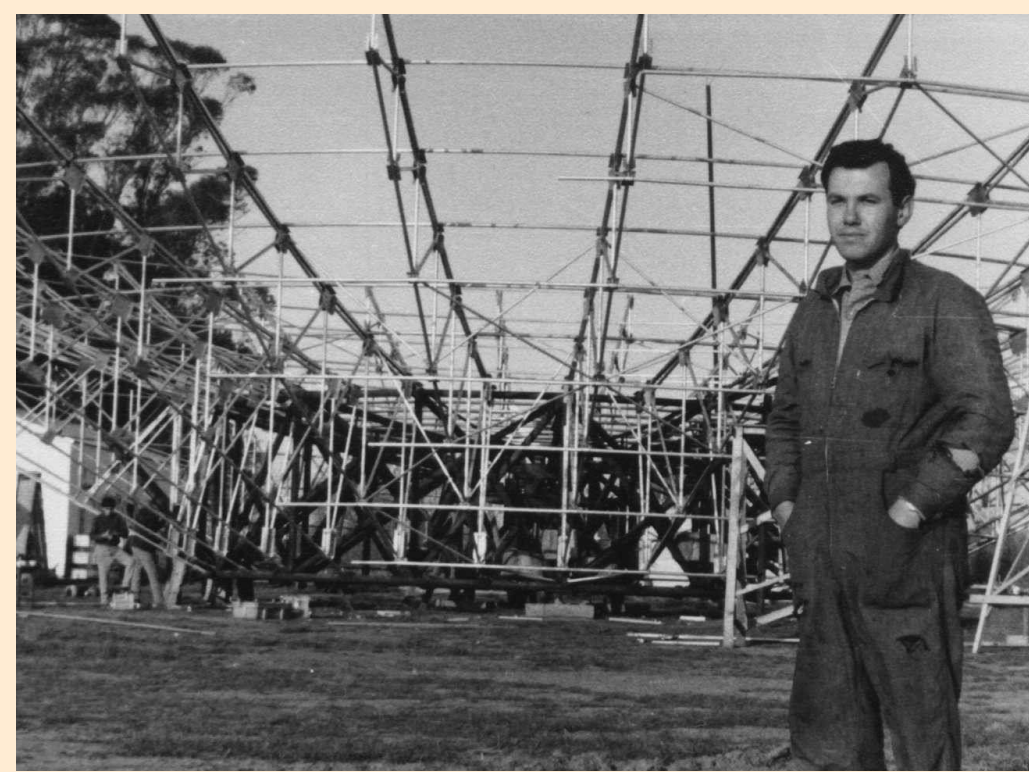
Armado de las costillas de la Antena I
