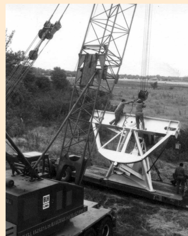
Montaje de la segunda Antena
