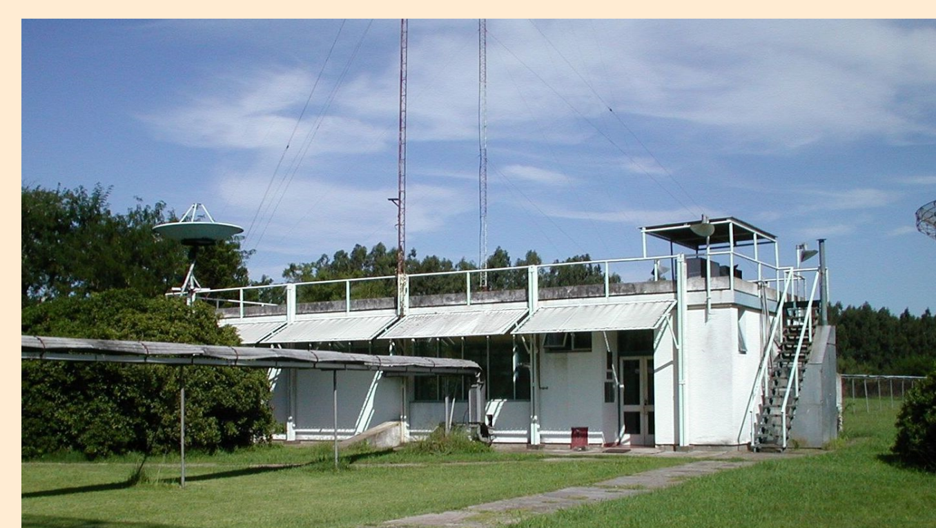
Vista exterior de la Sala de Control
