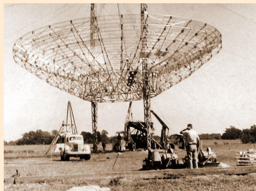
Montaje de la Antena I sobre la base
