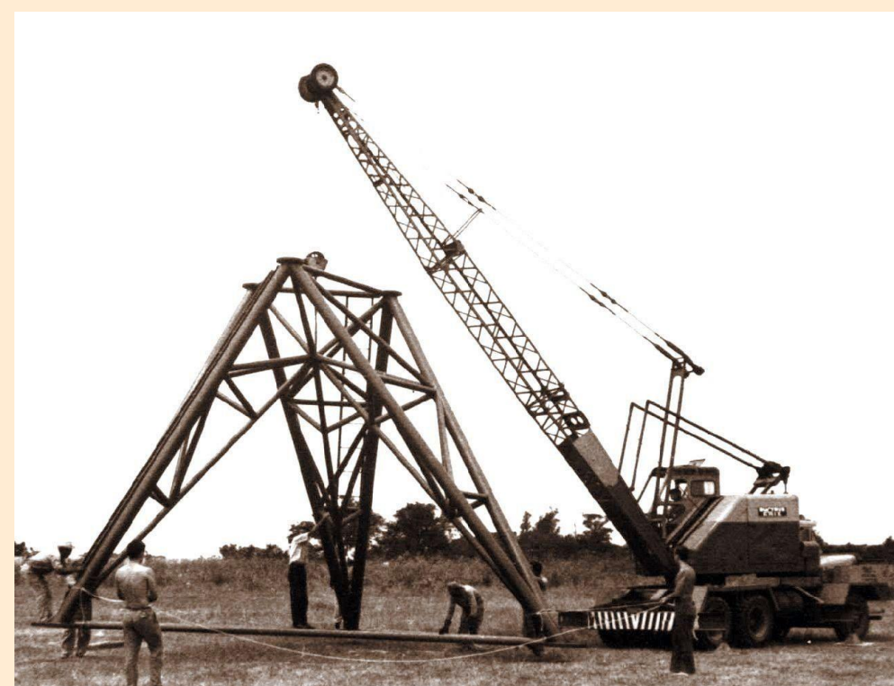
Armado del pie de la Antena
