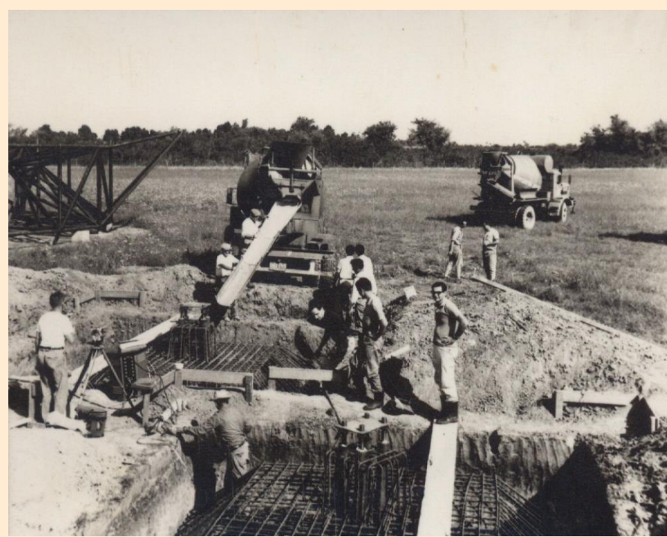
Llenado de las bases de la Antena I
