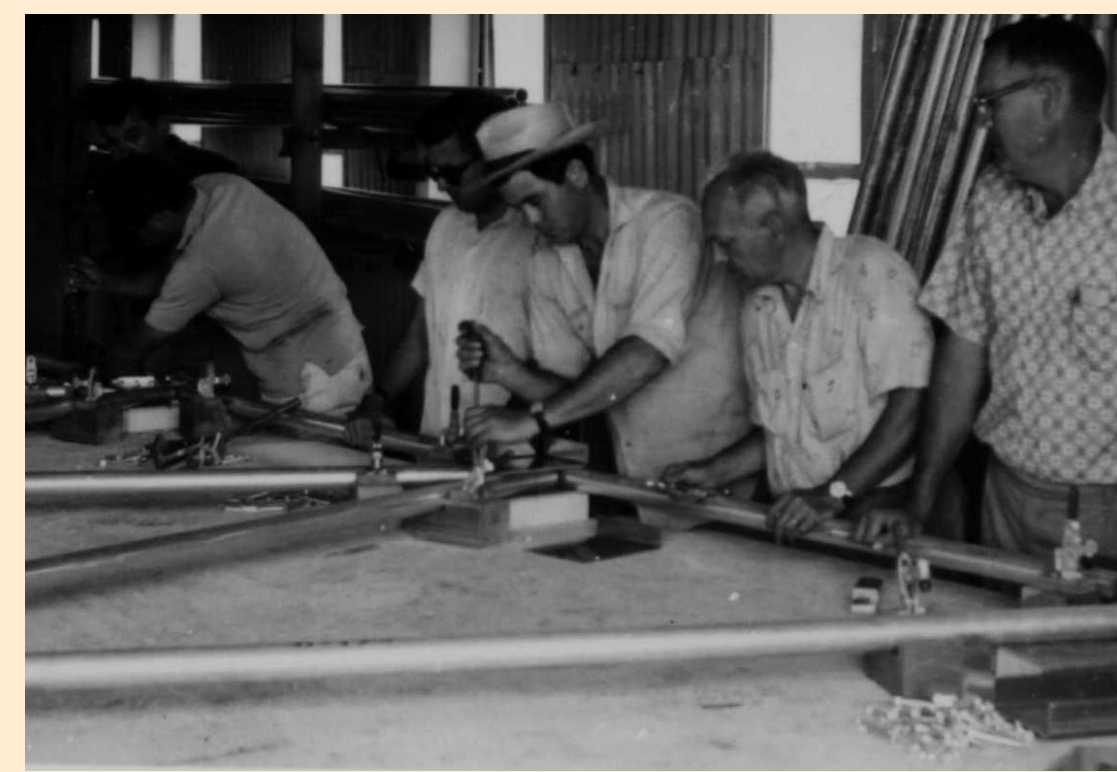
Armado de las costillas de aluminio
