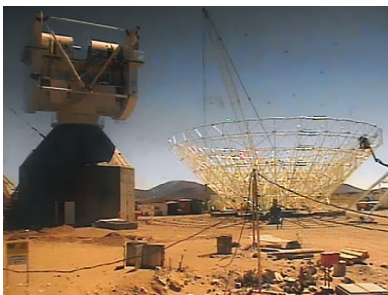
Avances en la construcción al 1/12/2011 (fuente)
